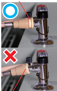
摺動部が隠れている
